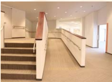
スロープの新設でバリアフリーを実現(展示室)
