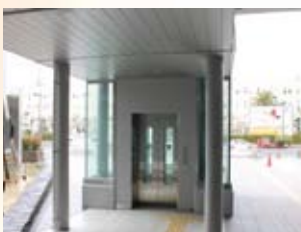
シースルーエレベーターを設置
