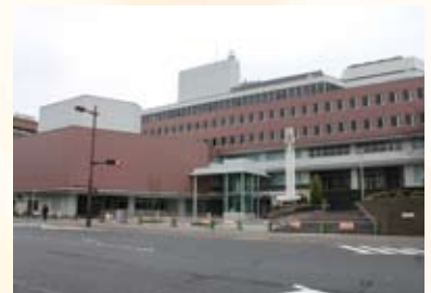
外壁も全面改修
